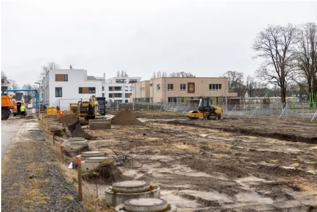
Die Erdarbeiten haben begonnen. In einem Jahr sollen die ersten Reihenhäuser der Firma Arning am Leedsring bezugsfertig sein. FOTO: ANDRE HAVERGO
