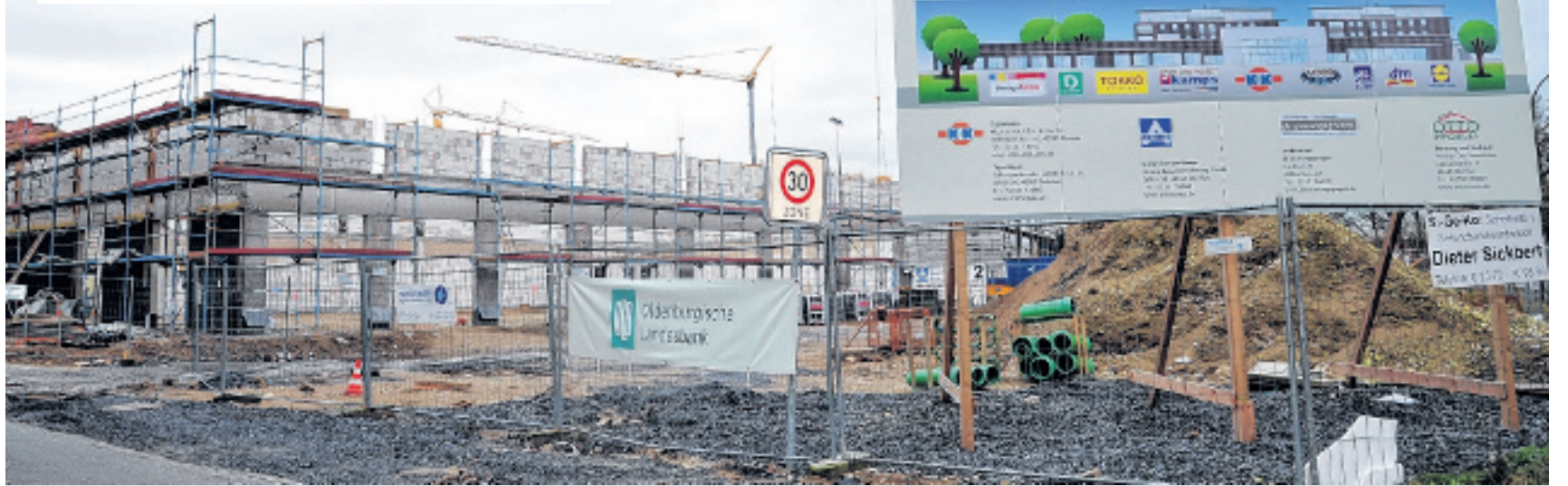
Auf dem Gelände laufen die Arbeiten am „Schlossparkcenter“ seit August 2013 auf Hochtouren (großes Bild). An der westlichen Seite des Zentrums wird eine Lärmschutzwand hochgezogen. (kleines Bild). Fotos: Kersten/Ernst
